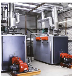
Remplacement de chaudière
