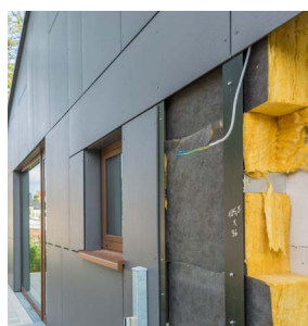
Isolation des murs par l'extérieur
