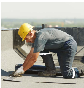
Isolation des toitures-terrasses
