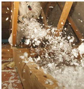
Isolation des combles
